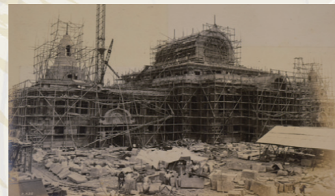
築地本願寺本堂(施工中)
