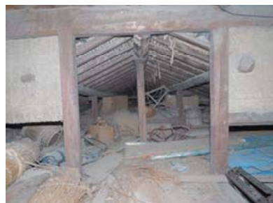
写真 3 増築に伴う棟木の延長 (F 邸)
