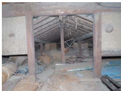
写真 3 増築に伴う棟木の延長 (F 邸)
