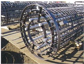
鉄筋かご(杭頭部)
