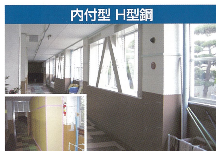
▲ 施工風景 (内部は使用しながら施工)
