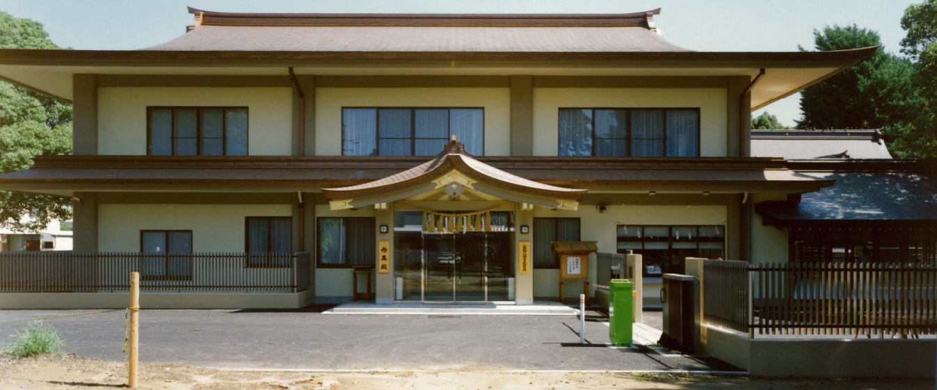
葛飾八幡宮社務所新築（千葉県市川市）
