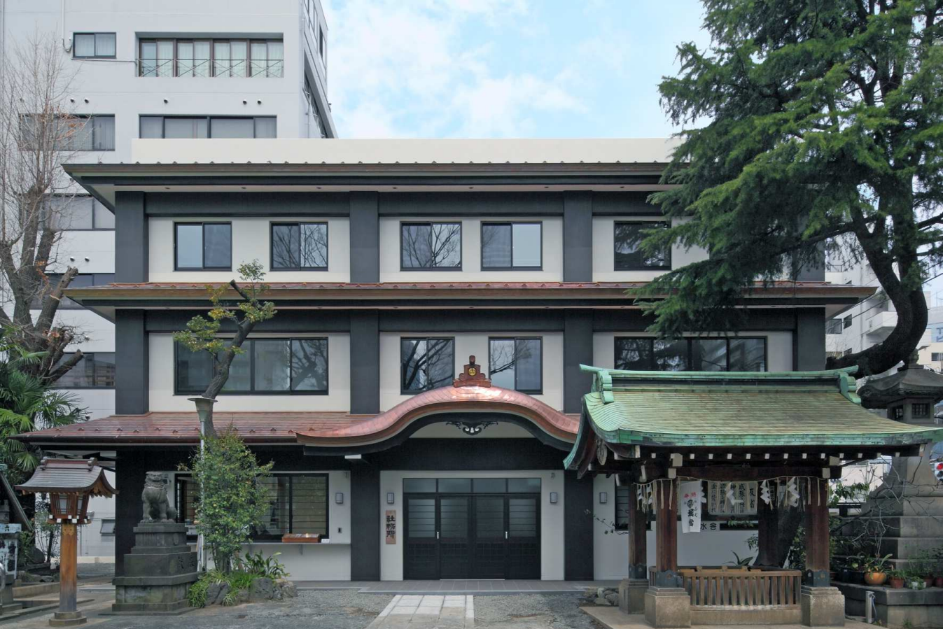
鉄砲洲稲荷神社社務所新築（東京都中央区）
