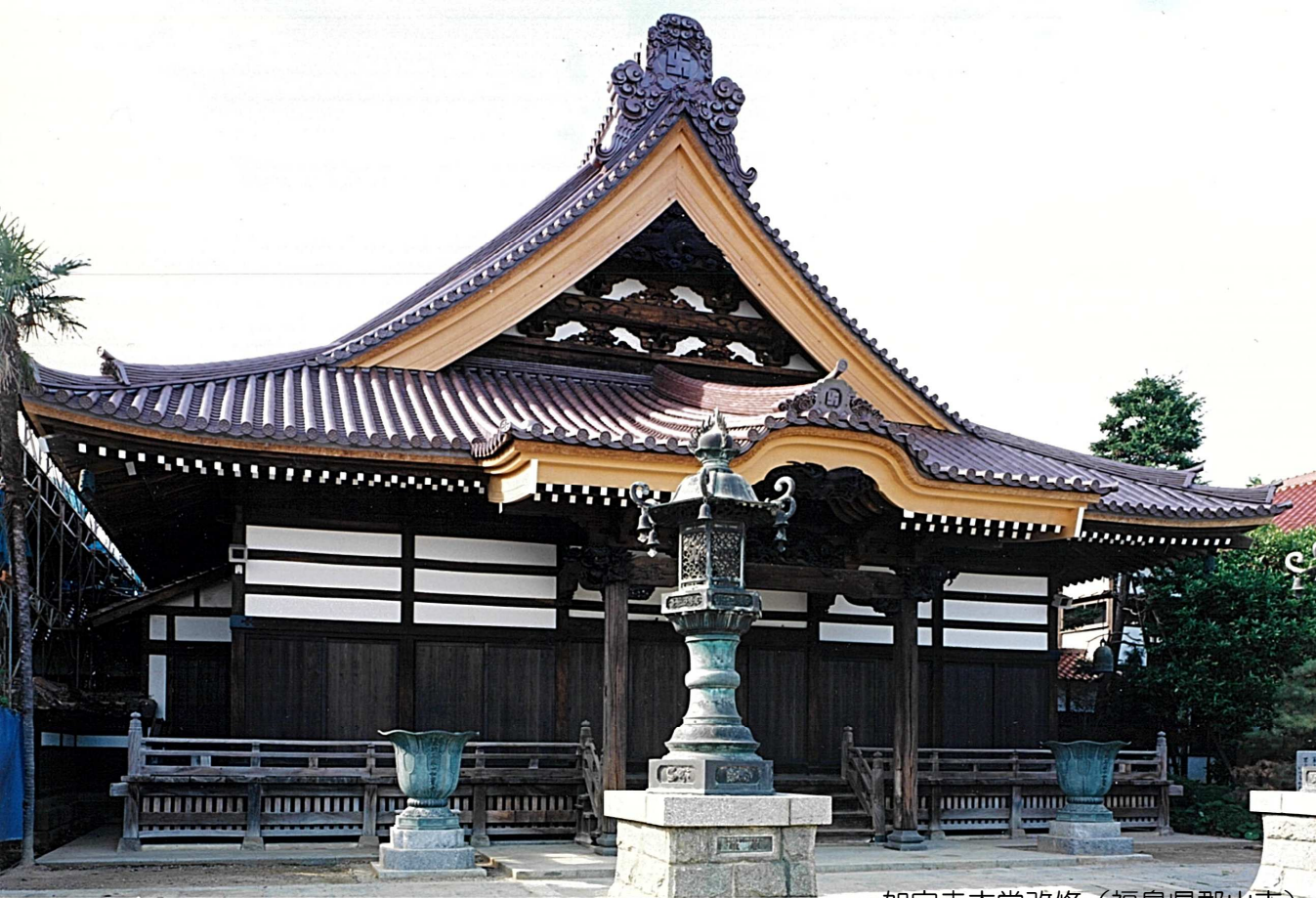
如宝寺本堂改修（福島県郡山市）
