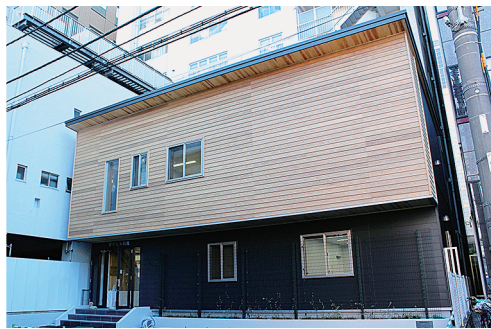
松井ビル別館外観
