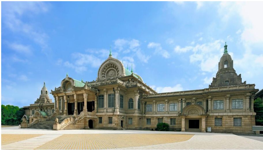
松井建設の名を広く世に知らしめることになった築地本願寺(写真提供:松井建設)
