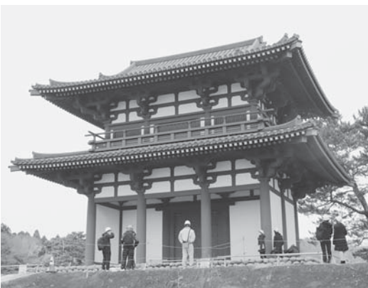
完成した多賀城南門
