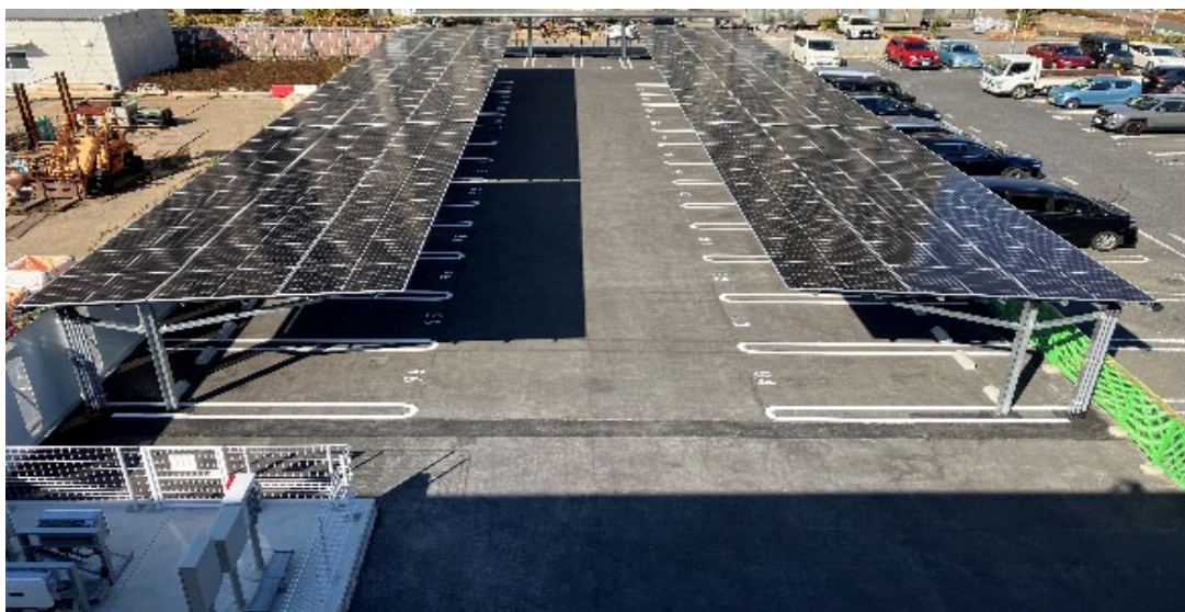
ふなばしソーラー発電所（千葉県船橋市）
