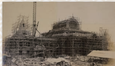
築地本願寺本堂復興工事
