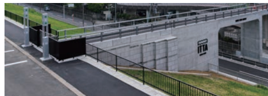
2025年度完成 R6荒川下流右岸板橋地区連絡路上部他工事 東京都
