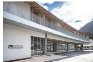
2025年度完成 白川町新庁舎建設工事 岐阜県
