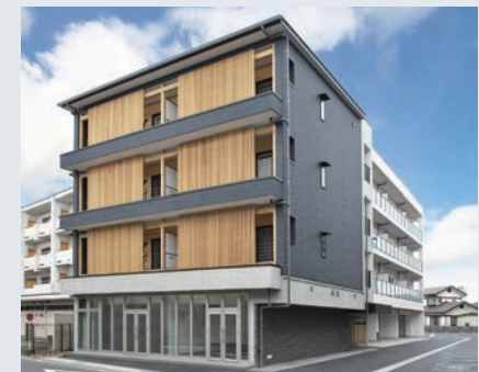
M-FLAT南仙台（竣工写真）
