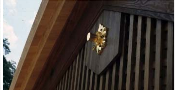
図 7. 劣化していた古書院東妻懸魚の六葉の金箔押しの復旧（左・修理前、右・修理後）「斎藤資料」より
