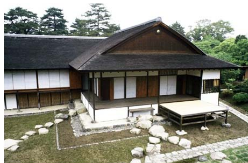
図 1. 桂離宮御殿外観（「斎藤資料」より）
