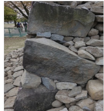
写真-3 全面に設置された介石
