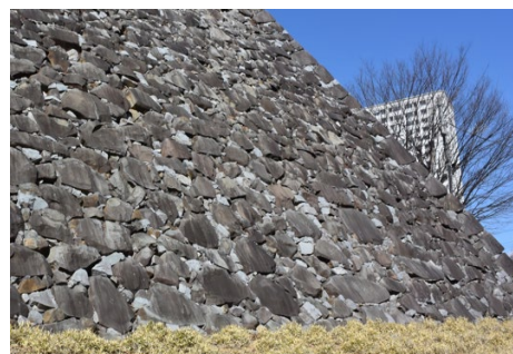
写真-2 間詰石を全面に詰めた例
