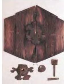
図 7. 劣化していた古書院東妻懸魚の六葉の金箔押し復旧 (左・修理前、右・修理後)「齋藤資料」より
