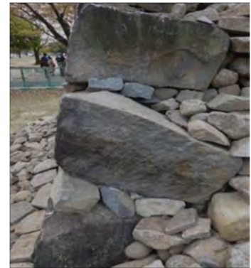
写真-3 全面に設置された介石
