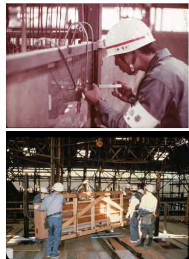
図4. 中書院土壁の大ばらし (樹脂注入による点接着、養生後の運び出しの様子)「斎藤資料」より
