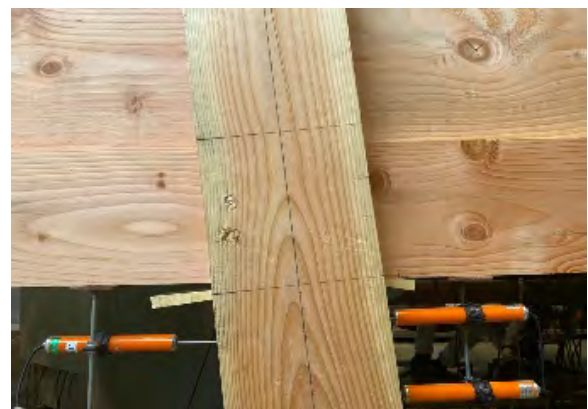
写真5 接合部回転角が 1/10\text{rad} 時の状況 (楔の抜け出しが確認出来る)
