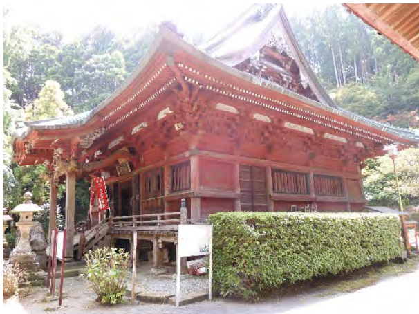
図1 大山寺不動堂の外観(北東より)
