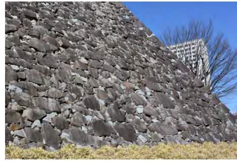
写真-2 間詰石を全面に詰めた例
