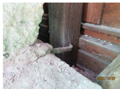
写真 3.9 木柱と石壁の鋕接合
