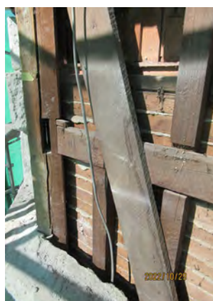
写真 3.11 貫・筋交いをういた軸組と木摺壁
