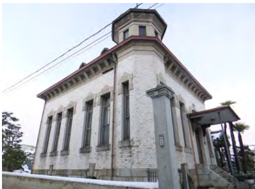
写真 3.3 東日本大震災後の奥山家住宅洋館
