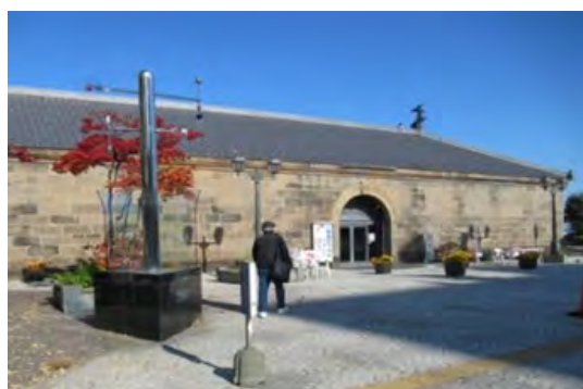
写真 2.4 地震モニタリングを実施している旧小樽倉庫
