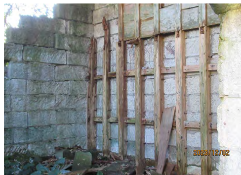
写真 付録 4 史跡・白石廣造邸 跡の木骨石造倉庫に残る木軸組
