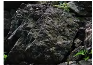
図 3 割れ石（犬山城天守台）
