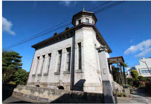
写真 3.6 2022 年 2 月 13 日福島県沖地震により被災した奥山家住宅洋館の補修後
