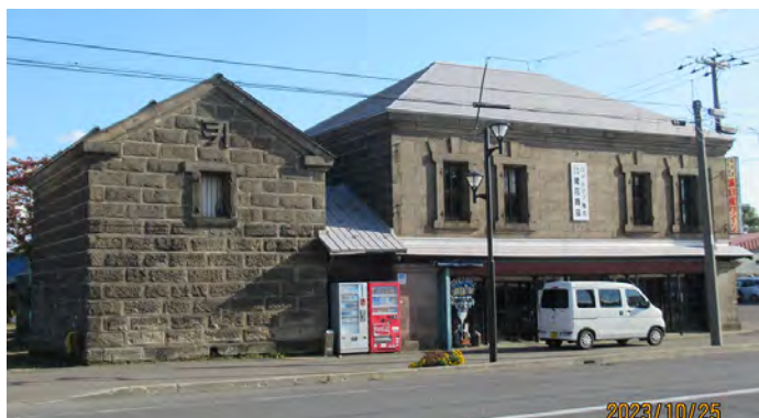
写真 付録2 浦臼町に建つ歴史的木骨石造建造物 尾花商店
