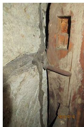
写真 2.2 渡邊家蔵 木柱と石壁の接合
