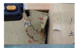
(b) 土塗壁隅角部の崩落 (+1/10 rad)
