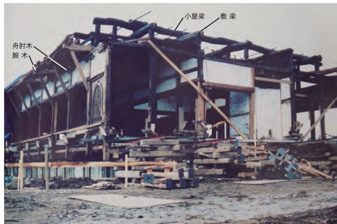
図2 ②曹洞宗・福厳寺客殿平成修理工事中(福厳寺提供)
