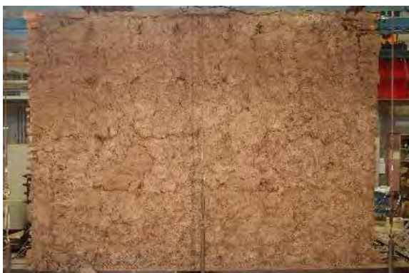
写真 3 実大大壁試験体の荒壁層からの壁土の脱落 3-4)
