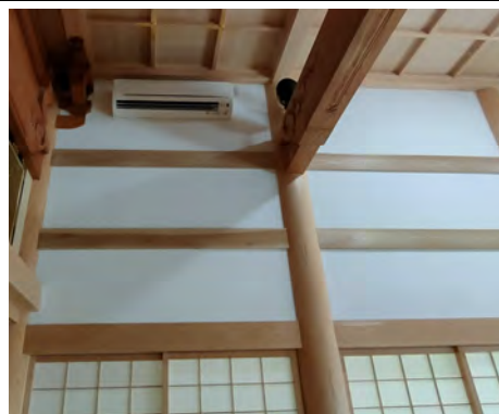
図 1 冷房 (エアコン) の設置例
