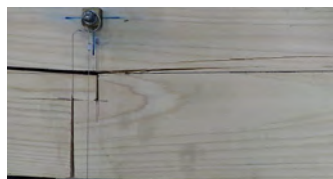
(e) 目違い接合部の割裂 (MJ 試験体)
