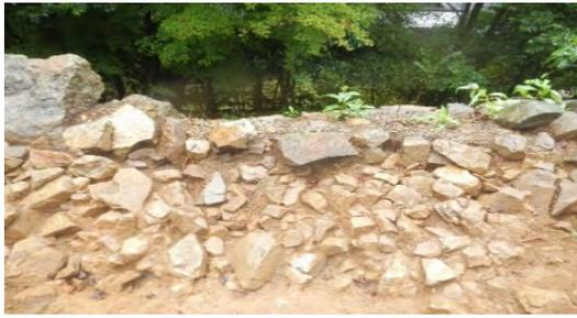
写真-4 土砂が混入した栗石層
