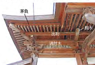
写真5 真如寺本堂 正面東側
