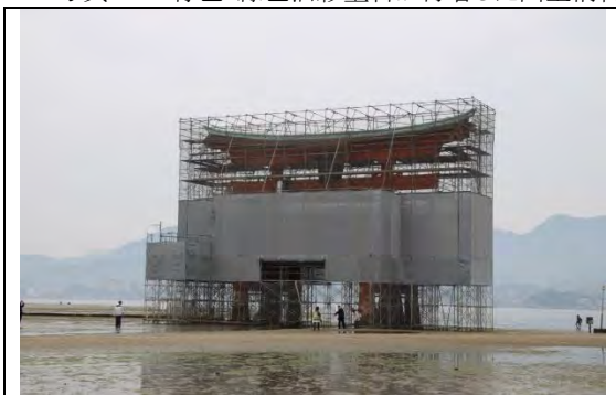
写真 7-1:修理終了後の現状(西側羽目板)
