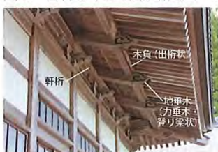
写真3 吉祥寺本堂 正面北側
