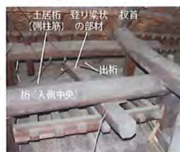
写真7 正善寺本堂 正面側 小屋組
