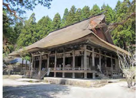
多雪地域に建つ伝統的木造建築物として、山形県寒河江市・本山慈恩寺の本堂(国指定重要文化財,1618 年)および同寺三重塔(県指定有形文化財,1830 年)を調査対象とした(写真1参照)。これらの文化財建造物の常時微動測定、地震モニタリング、構造解析を行った。屋根積雪は屋根葺き材の影響を受けるが、本堂は茅葺屋根、三重塔は銅板葺きであった。
