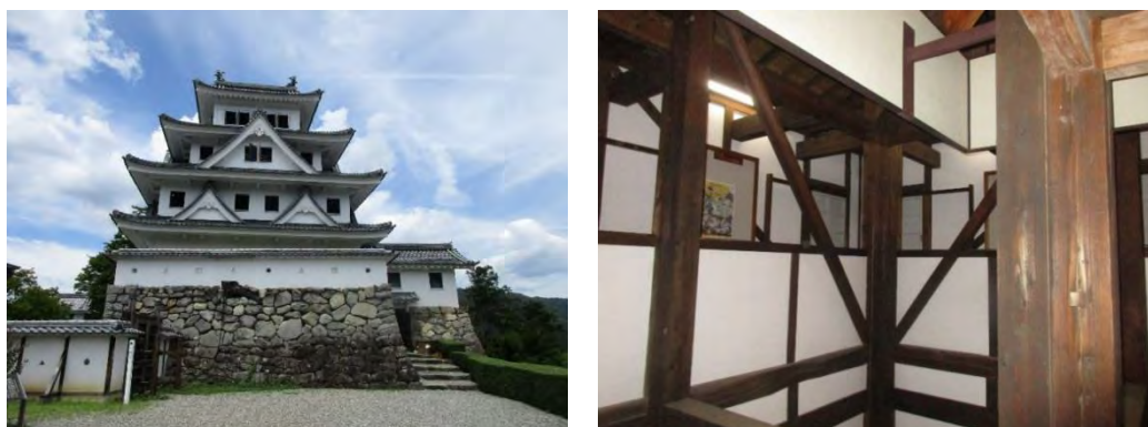
図1 建物の外観と内部の補強状況
