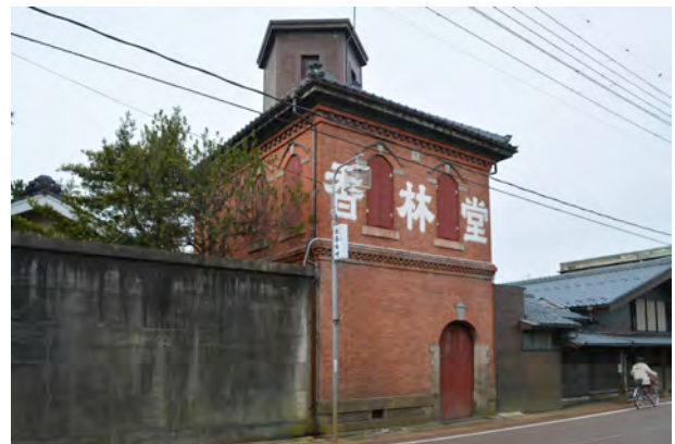
写真 2-2 今井家住宅 西洋館
