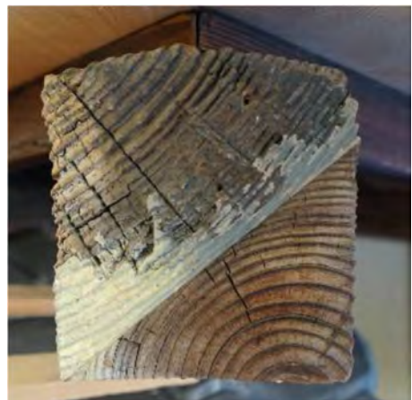
図5 人工木材による隅木の補修の例
