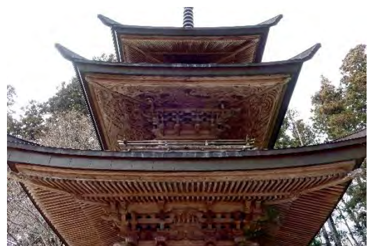
写真11：普門寺三重塔 軒見上げ
