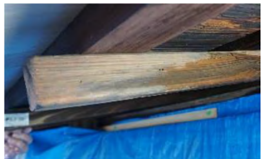
図4 人工木材による垂木の補修の例
