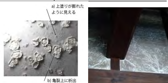
図1 並大津壁の劣化状況（左：広範囲に析出がみられた箇所の拡大、右：線状に劣化している箇所）
