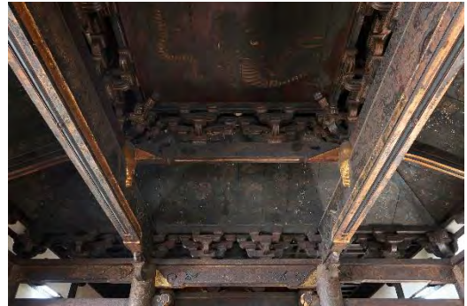
写真10：本興寺開山堂 内陣見上げ
