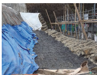
写真-1 仙台城石垣工事でのジオテキスタイルの敷設状況
