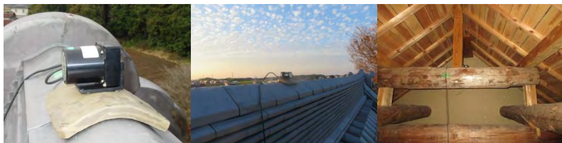
図2 速度計設置状況（左:速度計、中央:棟瓦上、右:小屋組）
