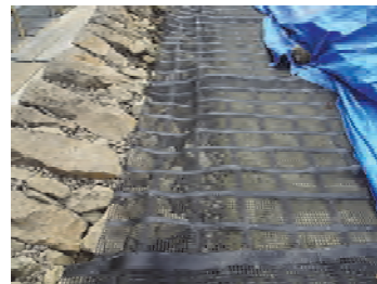
写真-1 仙台城石垣工事でのジオテキスタイルの敷設状況
