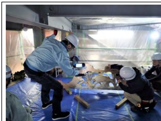
延暦寺根本中堂彩色葦股の三次元計測風景
