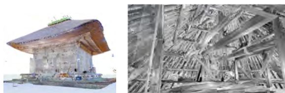
図 2 取得した清水寺観音堂の点群データの 外観（左）と小屋裏（右）
