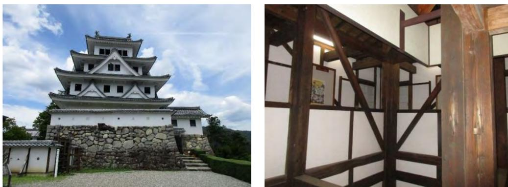
図1 建物の外観と内部の補強状況
