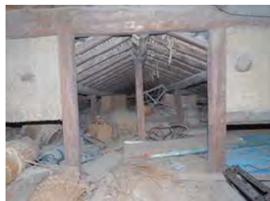
写真 3 増築に伴う棟木の延長 (F 邸)
