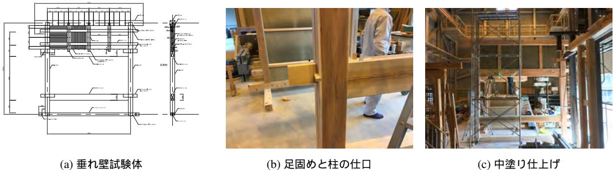
図2: 垂れ壁試験体の軸組図と製作過程
