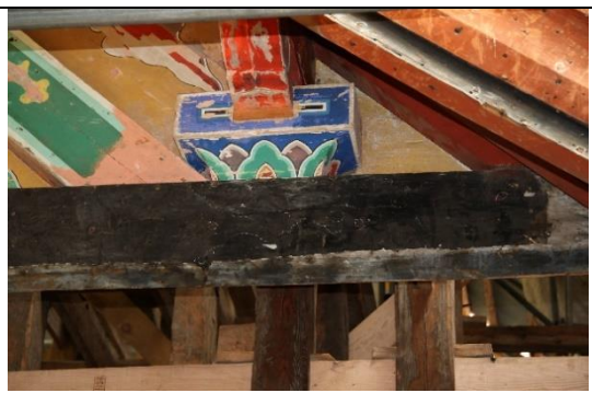
写真 3-2: 同 修理終了後の現状(東側羽目板)
