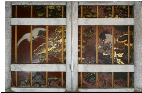
写真 4-1:修理終了後の現状(西側羽目板)
