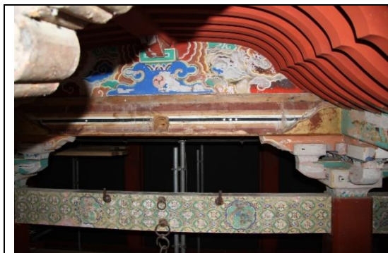
写真 3-1: 修理終了後の現状(西側羽目板)
