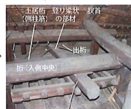
写真7 正善寺本堂 正面側 小屋組
