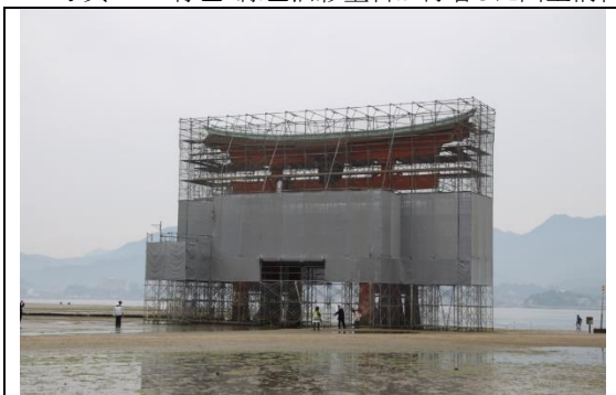
写真 7-1:修理終了後の現状(西側羽目板)
