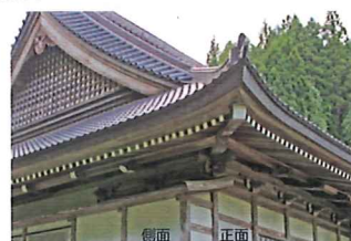
写真4 吉祥寺本堂 南東側隅
