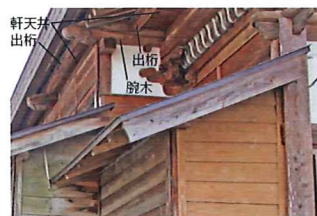
写真6 真如寺本堂 東側面北側
