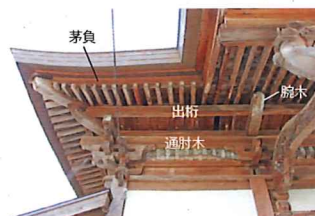
写真5 真如寺本堂 正面東側
