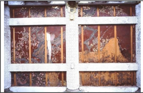
写真 4-2:同 修理終了後の現状(東側羽目板)
