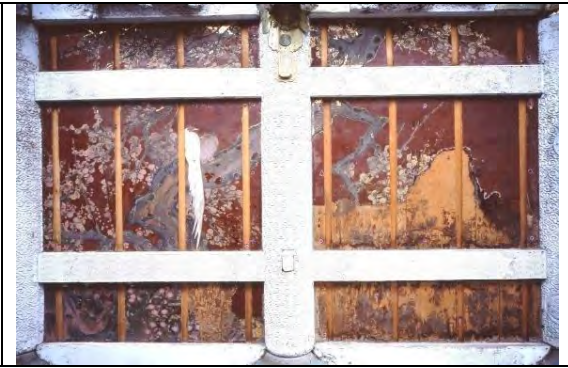
写真 4-2:同 修理終了後の現状(東側羽目板)
