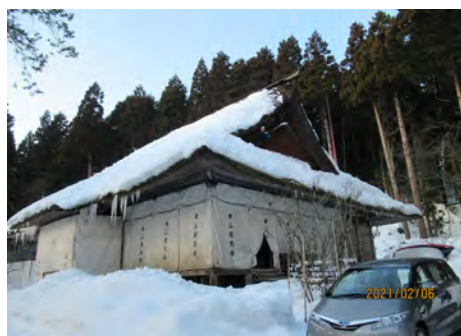
写真 3 雪下ろし直後の本堂 微動測定実施 (2021 年 2 月 6 日)
