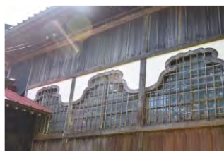
図8 本殿の外壁と垂木
