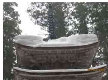
写真 4 羽黒山五重塔の 積雪状況(2021 年 2 月 6 日)
