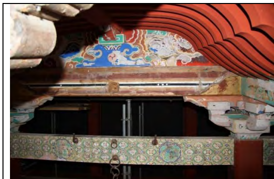
写真 3-1: 修理終了後の現状(西側羽目板)
