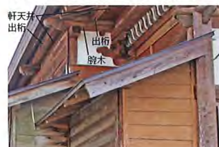
写真6 真如寺本堂 東側面北側
