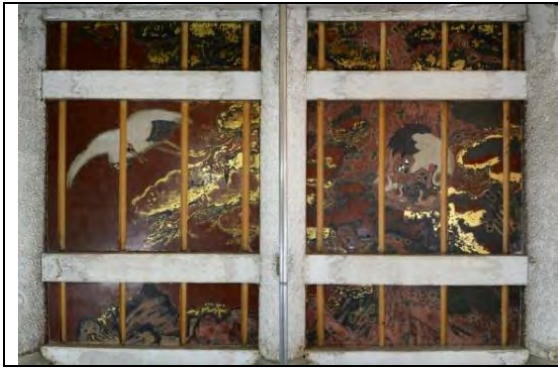
写真 4-1:修理終了後の現状(西側羽目板)
