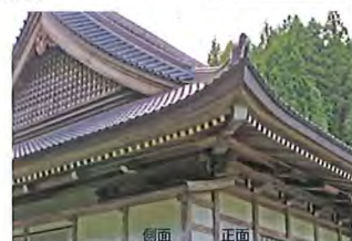
写真4 吉祥寺本堂 南東側隅
